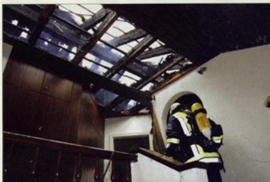
Einsturzstelle: Das Feuer hatte sich oberhalb des Flures, nicht erkennbar ausgebreitet. Nach einem lauten Krachen brachen auf ca. 10 Quadratmetern die Holzlatten der Verkleidung, Ziegel und Dachbalkenteile herunter.
