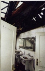
Glutheißer Strahl: Aus der Zwischendecke fließt das heiße, zu einer schwarzen Flüssigkeit geschmolzene Styropor herab.
